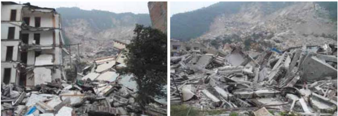
再结实的房子，也不可能经得住这样的山体滑坡冲击呵！
